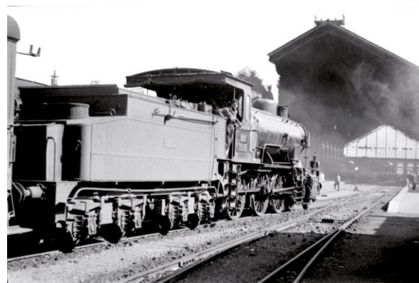
Un tren remolcado por una locomotora de vapor accediendo a la estación de Delicias en los años cincuenta. Fondo AHF.
