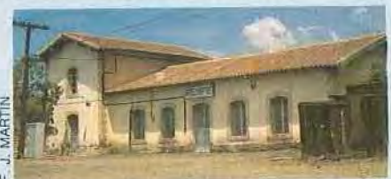
La estación de Nacimiento (origen de la primera electrificación española), ha quedado clausurada por estar fuera del nuevo trazado.
