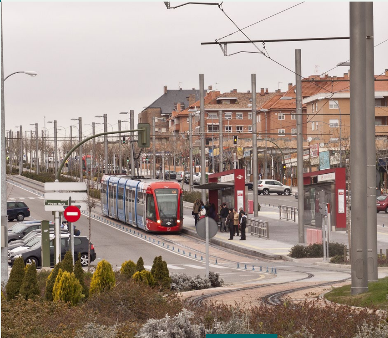
Metro Ligero Oeste.
