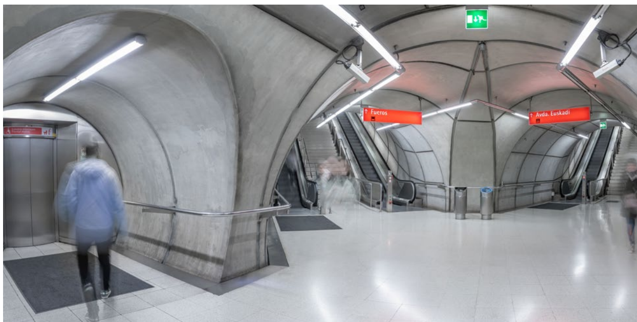
Todas las estaciones de Metro Bilbao son accesibles a personas con movilidad reducida (en la imagen, estación de Barakaldo).
