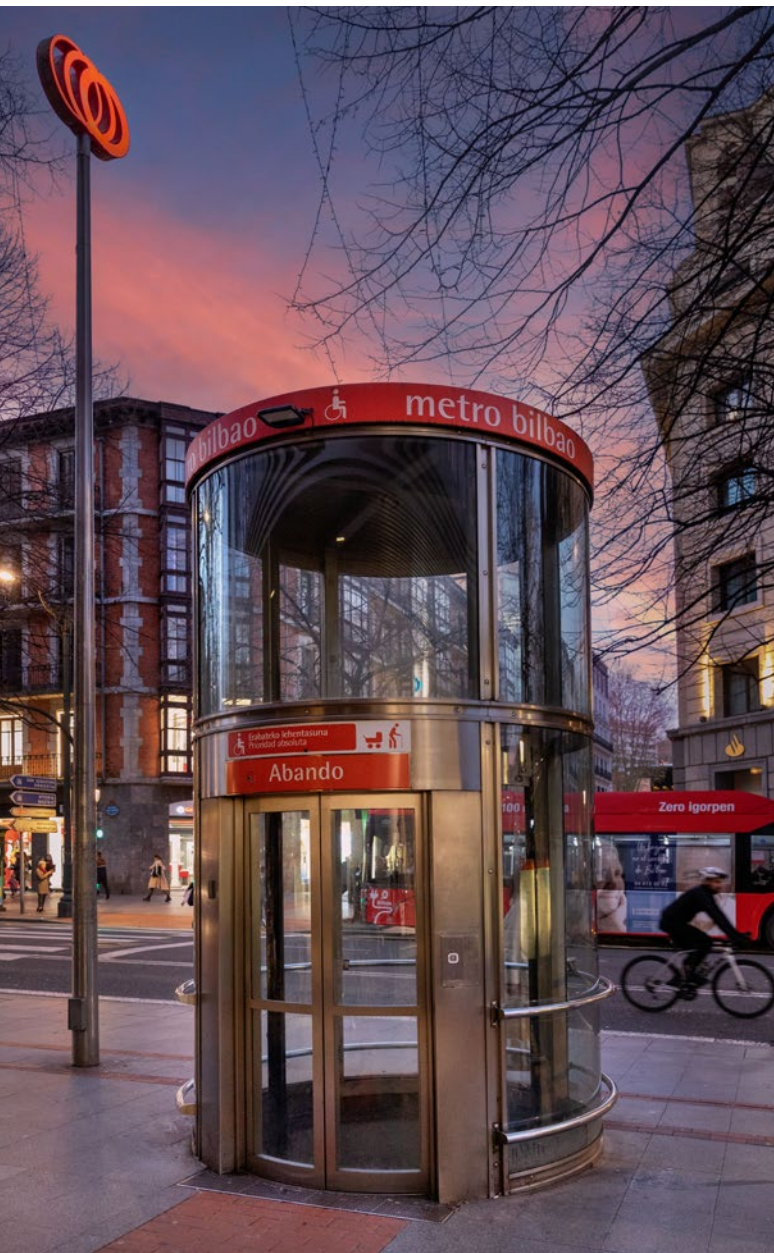
Ascensor y fosterito de Abando.
