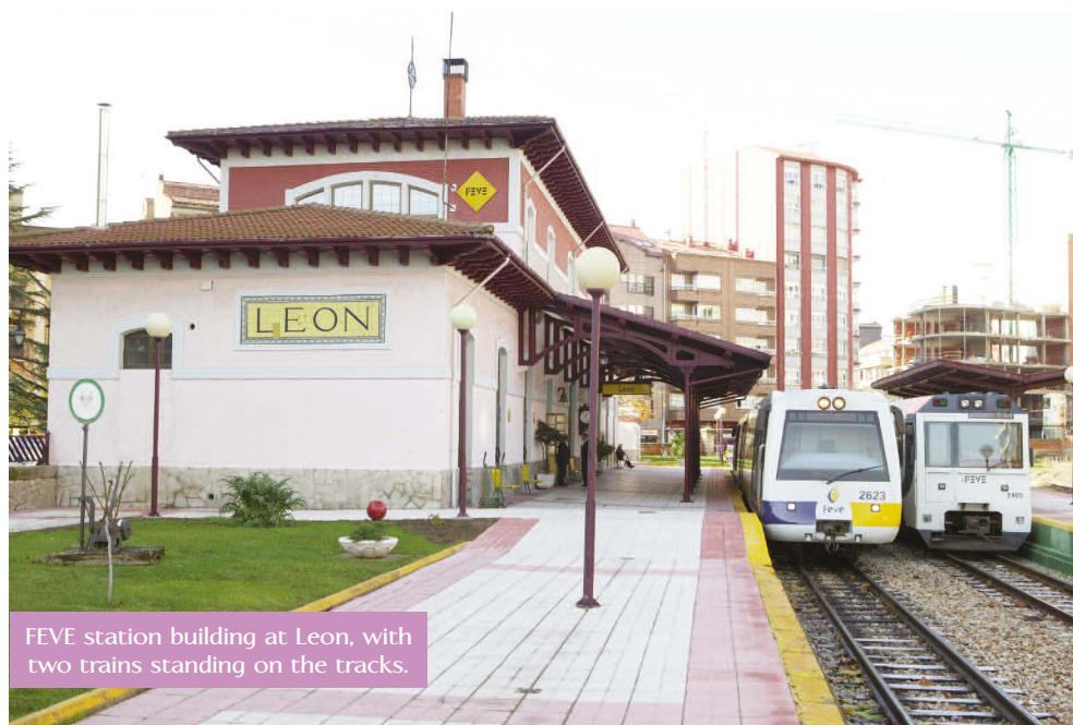
Edificio de la estación de FEVE de León con dos trenes estacionados sobre las vías.
