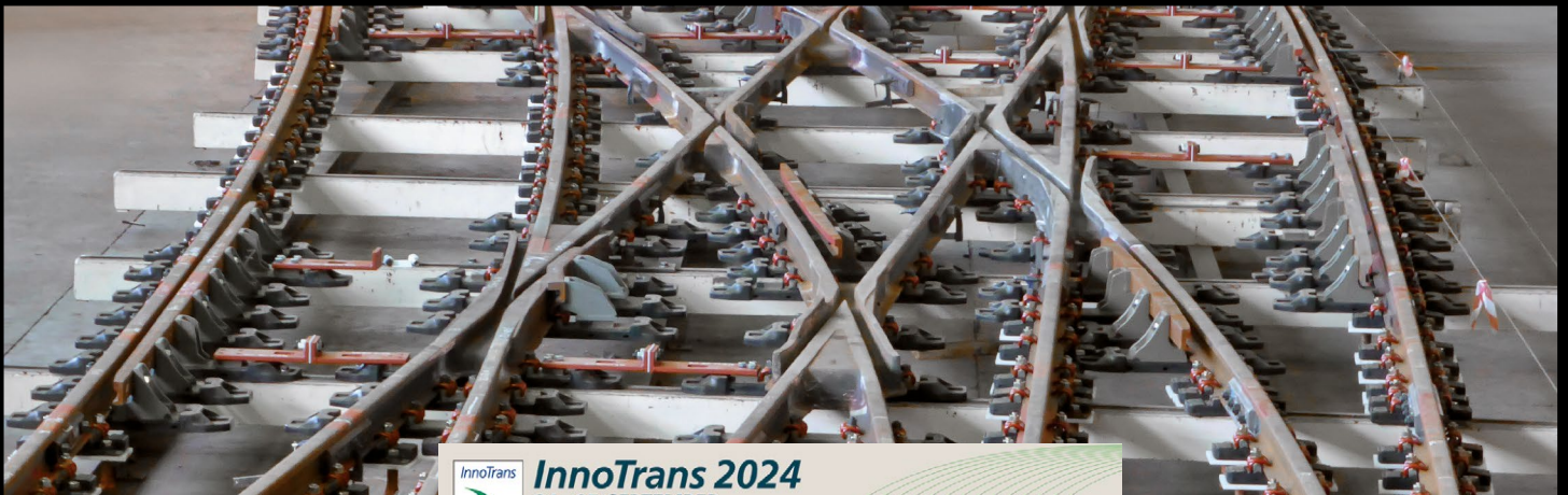
Desvíos y material fijo de vía
