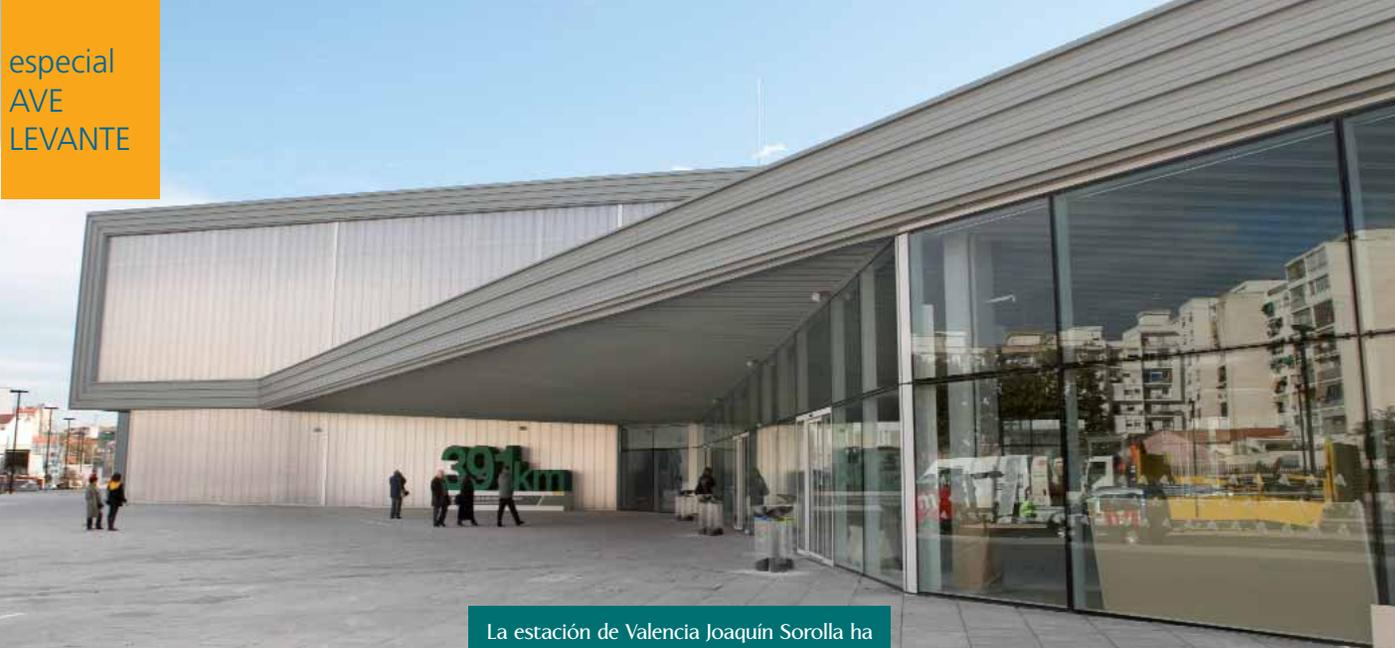
La estación de Valencia Joaquín Sorolla ha utilizado el policarbonato como elemento básico de fachada y en interiores.
