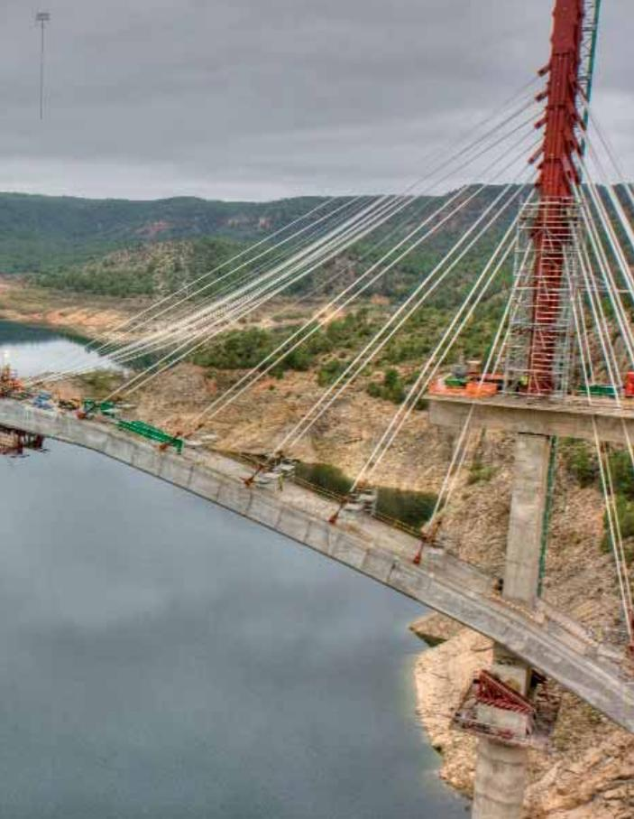
La construcción comenzó en agosto de 2008 con las cimentaciones de los pilares de acceso al arco y los dos plintos de éste, con más de 3.000 metros cúbicos de hormigón en cada uno de ellos.
