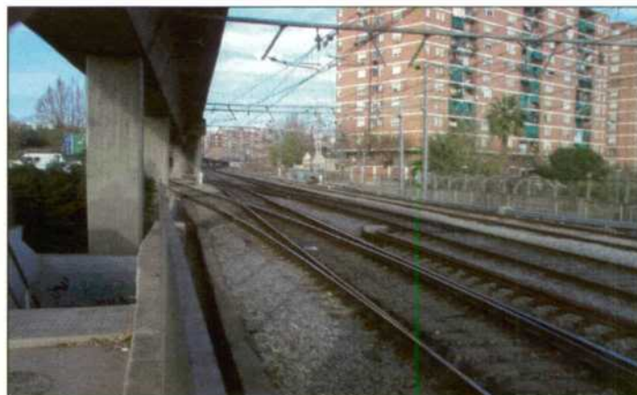
En la Bifurcación Gornal sólo se mantiene una vía, la del desvío más próximo en la foto. Por encima de ella, pasa la que era la vía del aeropuerto que ahora es la general impar de Barcelona hacia Madrid.
