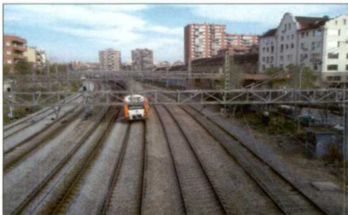
En la entrada de Sants hay seis vías. Las dos de la derecha han sido dadas de baja para las obras. La vía por la que circula el electrotrén es ahora la general de entrada a Barcelona, y las de la derecha, en las que se ven trenes de Cercanías, son las generales de Vilafranca.
