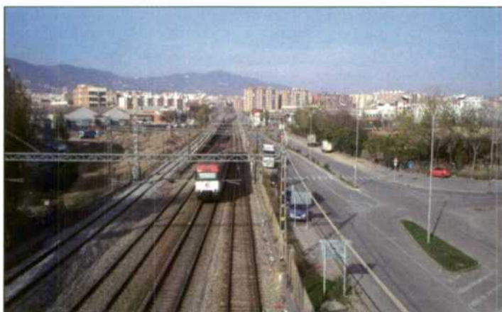
A la salida de Bellvitge hacia Barcelona hay cuatro vías. Por la que circula la unidad ha sido dada de baja el día 3 de diciembre. Solo están útiles ahora las dos vías de la izquierda, una de la cuales era la del aeropuerto, que en la imagen comienza su subida para pasar sobre la Bifurcación Gornal.
