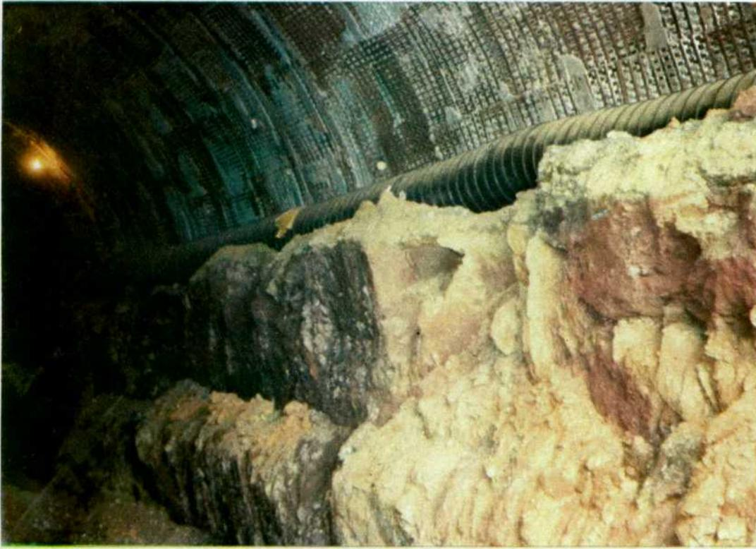
Bóveda hormigonada y excavación de la destroza central.
