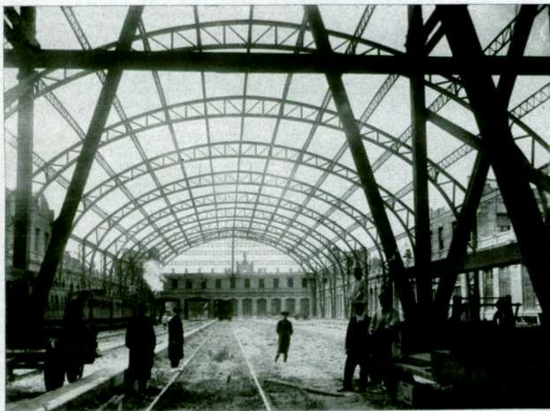
Año 1911. Montaje de la gran marquesina de la (entonces) nueva estación valenciana del Norte, con fachada principal a la calle Játiva.
