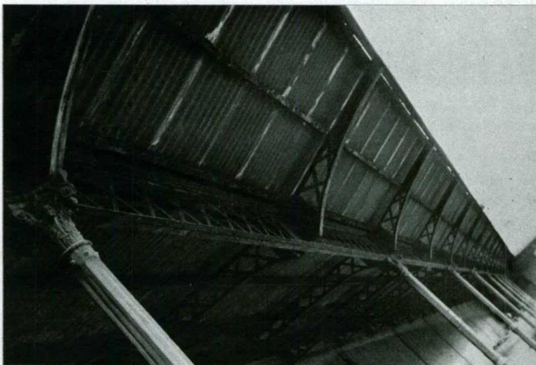
Detalle de la cubierta metálica, que sostienen veintitrés columnas de hierro con hermosos capiteles compuestos.
