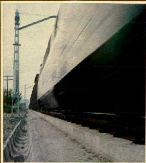
Un tren de viajeros atraviesa el tramo de "vía en placa". Obsérvese el sistema lateral de desagüe.
