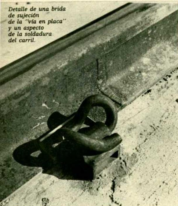
Detalle de una brida de sujeción de la "vía en placa" y un aspecto de la soldadura del carril.
