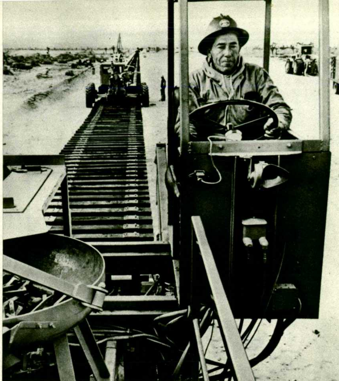
En los últimos años se han renovado en los Estados Unidos unos cincuenta mil kilómetros de vía, que han sido colocados, generalmente, por máquinas como la de la fotografía, que en una serie de procesos colocan las traviesas, las planchas y los raíles e incluso guía los tirafondos, evitando así días de trabajo exhaustivo.
