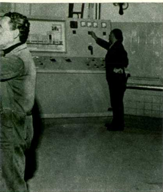
Aquí se produce la energía térmica para alimentar los circuitos de agua caliente y de calefacción en el Centro de Fuencarral.
