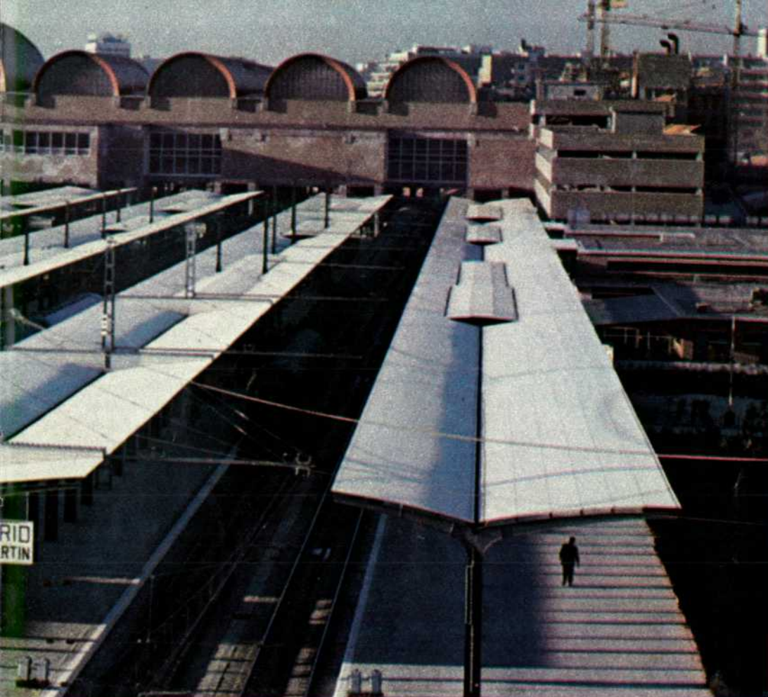
Panorama general de los andenes y la fachada Norte de la estación.
