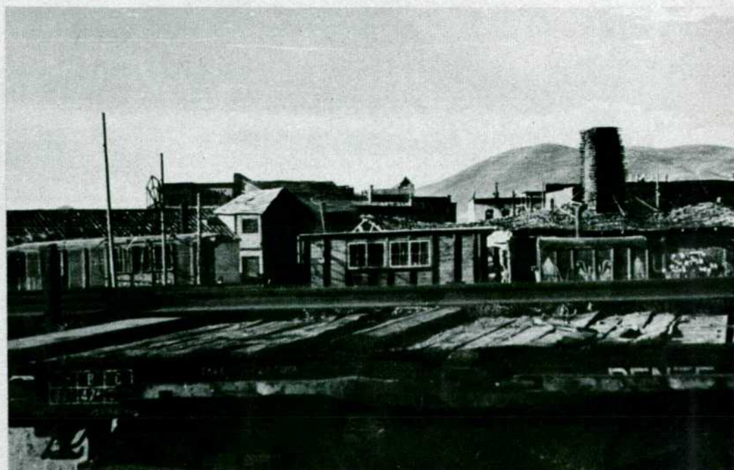
Perspectiva parcial del poblado del «Far-West», desde el andén de la estación de La Calahorra.
