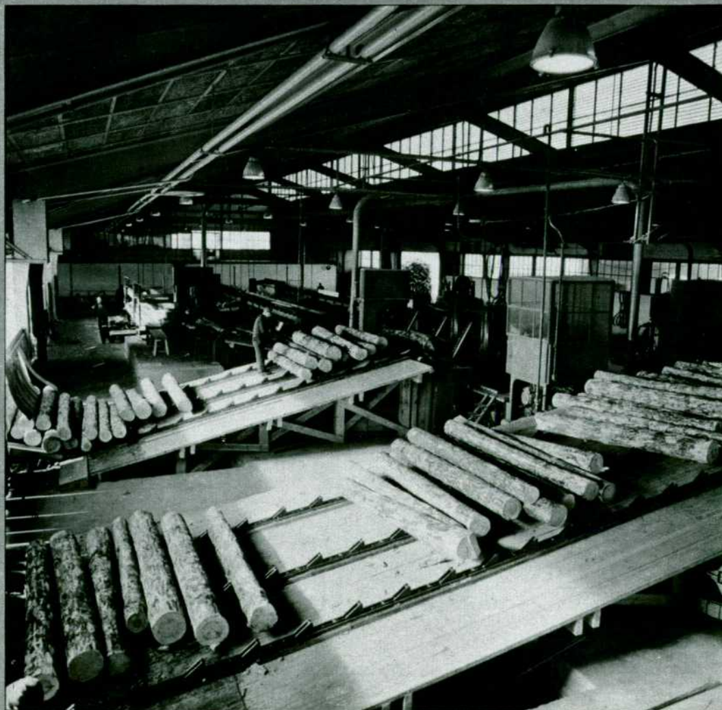
Entramos en la nave de serrería por una rampa de entrada de madera en rollo y pude darme cuenta de la cantidad de máquinas que me esperaban.
