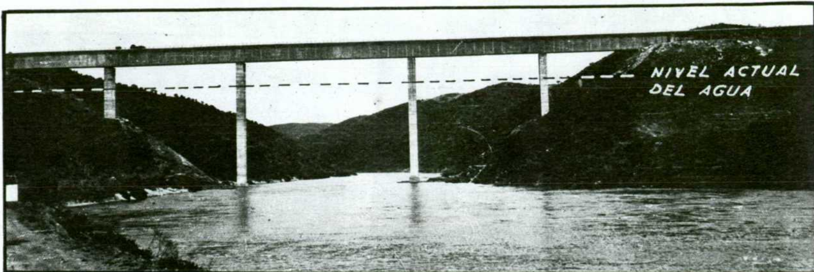
El nuevo puente mixto (ferrocarril-carretera) sobre el río Tajo, antes de empezar el embalse de las aguas, cuyo nivel actual se señala en la foto.
