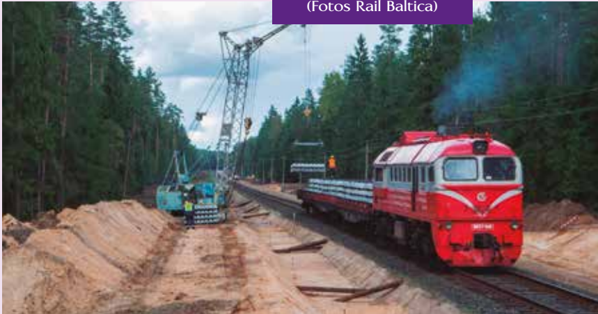
Trabajos de plataforma en la zona de Marijampolė. (Fotos Rail Baltica)
