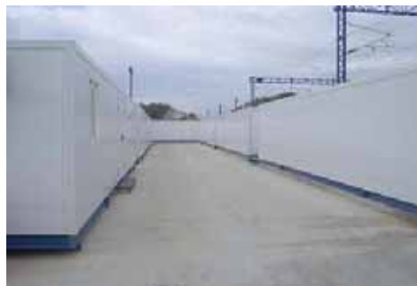
Plataforma de los cambiadores de Talgo (izquierda) y CAF (derecha). A la izquierda, plataforma abatiéndose verticalmente. A la derecha, casetas que ayudan a la portabilidad a los cambiadores de tercera generación
