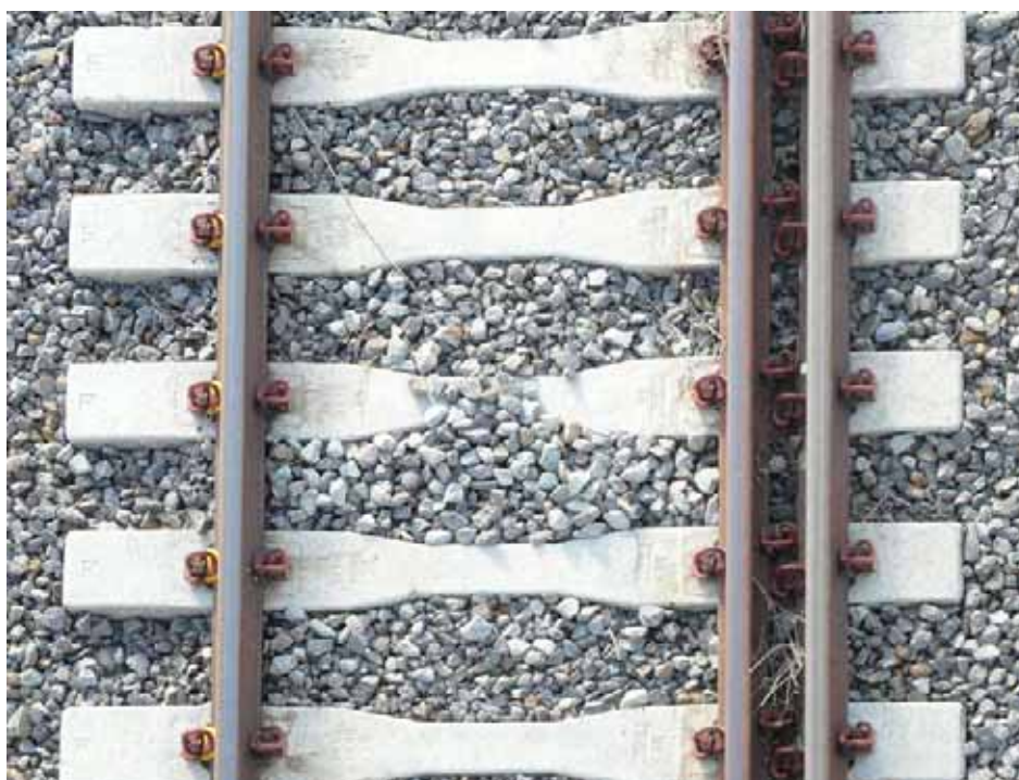
En la vía de tres carriles se puede apreciar la diferencia entre el ancho estándar (1.435mm) y el ibérico (1.668mm). La foto está tomada en Pozal de Gallinas, en el tramo de ensayos de Olmedo a Medina del Campo
