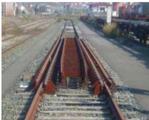
Cambiador para tecnologías Rafia y SUV-2000 instalado en Irún para pruebas
