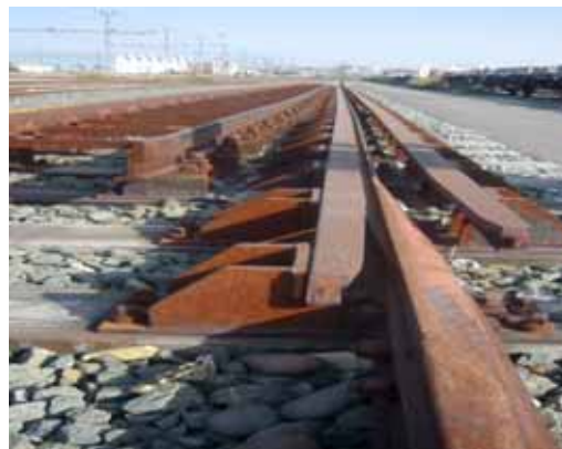
Cambiador para tecnologías Rafia y SUV-2000 instalado en Irún para pruebas
